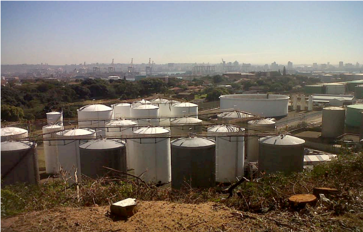
Fig.3: Tanques da Engen
